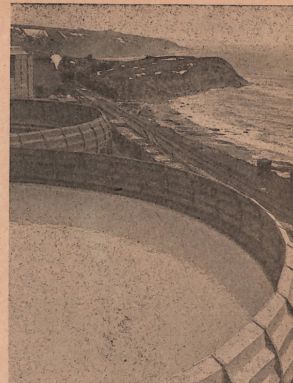
Valtava saostussäiliö, jossa meriveteen lisätään kalkkia. Tämä on ensimmäinen vaihe valmistettaessa magnesiumia merivedestä.
