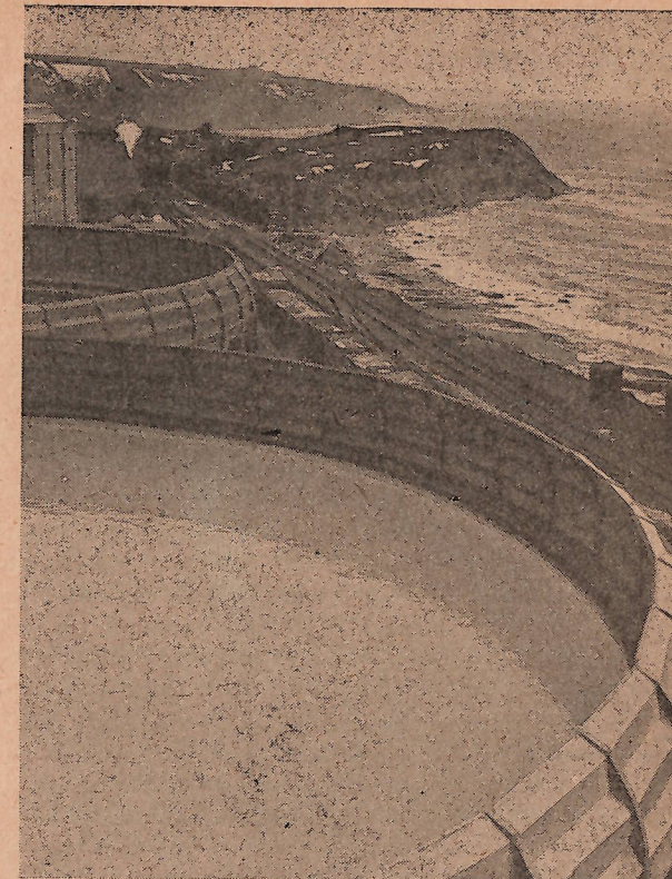
Valtava saostussäiliö, jossa meriveiteen lisätään kalkkia. Tämä on ensimmäinen vaihe valmistettaessa magnesiumia merivedestä.
